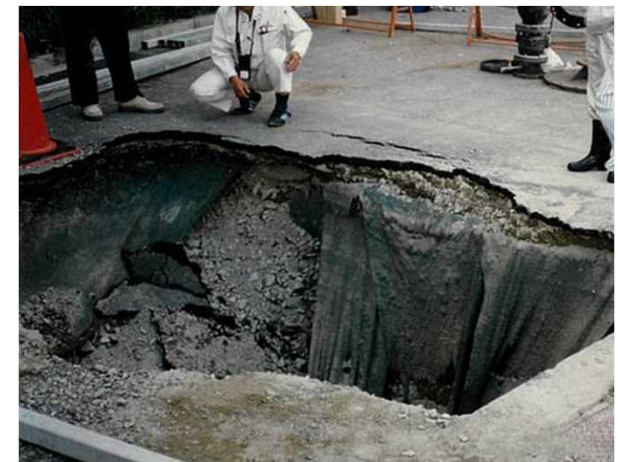
事故現場写真 (埋設管φ1800からの漏水で農道が陥没)
