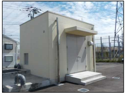
供給点局舎・遠隔制御の子局整備
