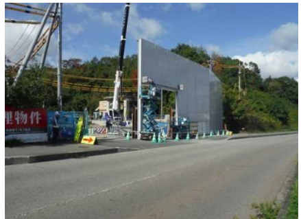
シールド工立坑外観 (山口工区)
