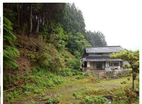
④保全対象の状況
