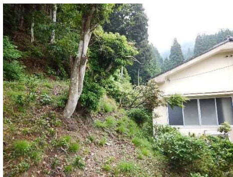
③斜面(人家裏)及び保全対象の状況
