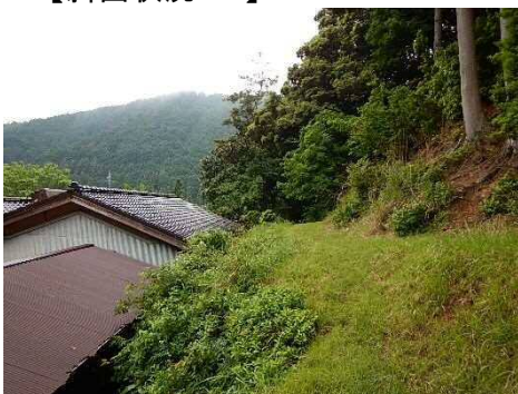
②斜面(人家裏)及び保全対象の状況
