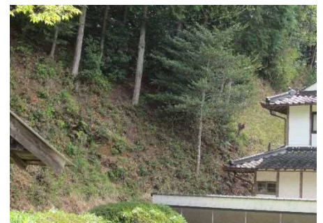
④保全対象とがけの状況
