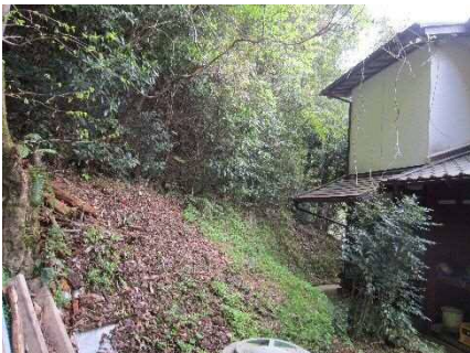
②保全対象とがけの状況
