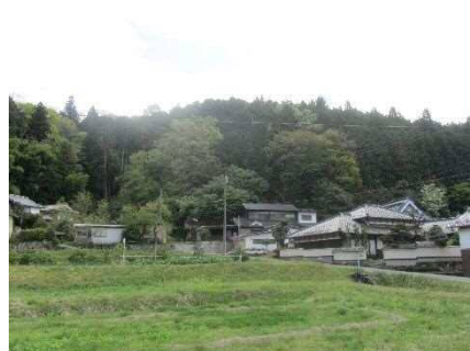
③保全対象(人家)
