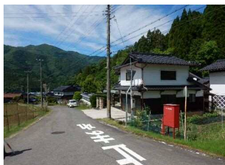
③保全対象(人家)
