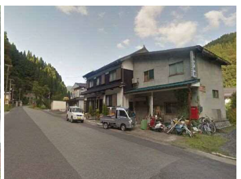
④保全対象(人家)
