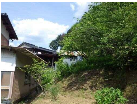
②斜面状況(人家裏)
