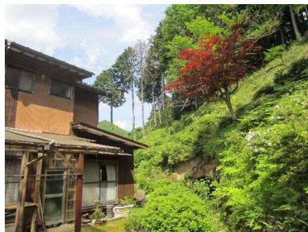
③斜面(人家裏)及び保全対象の状況
