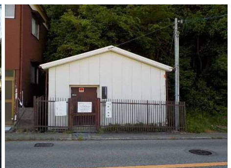
④保全対象の状況(水道施設)
