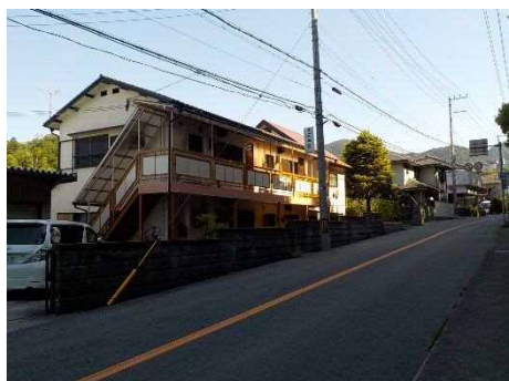
③保全対象の状況
