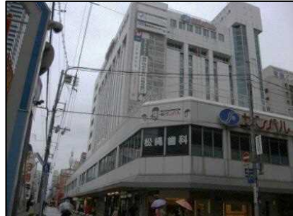
②施設の耐震性不足
