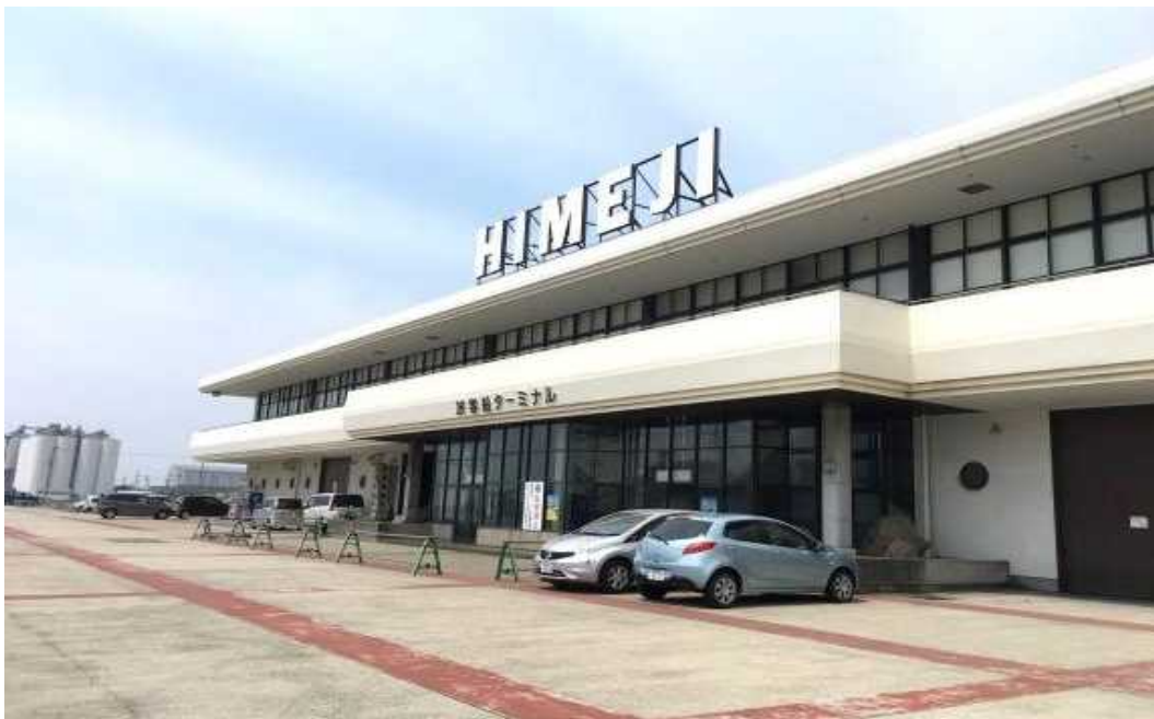
旅客船ターミナル（岸壁側外観）
