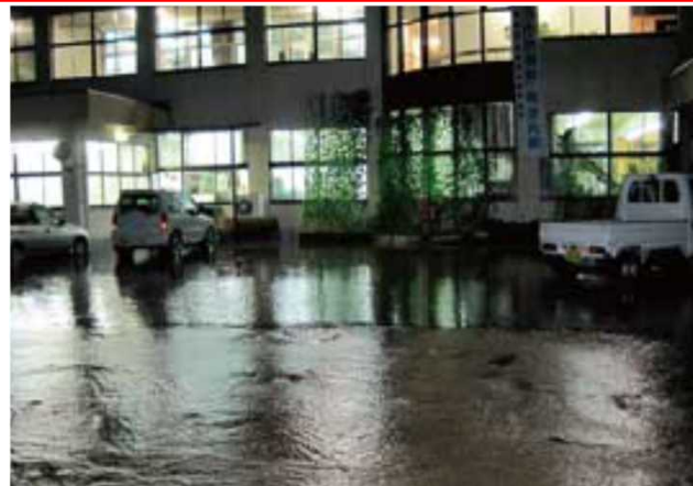
引原川と揖保川合流点 一宮市民局駐車場浸水状況:(宍粟市安積町) ダム-4
