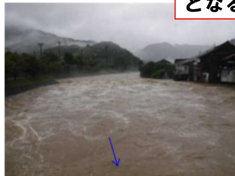
平成30年7月7日 6:00頃 上野水位局付近H=2.87 m (氾濫注意水位H=2.80 m) 波賀橋上流 左岸堤防高まで水位が上昇 ダム-6
