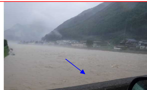
平成30年7月7日 6:00頃 三軒家水位局付近 右岸堤防高まで水位が上昇
