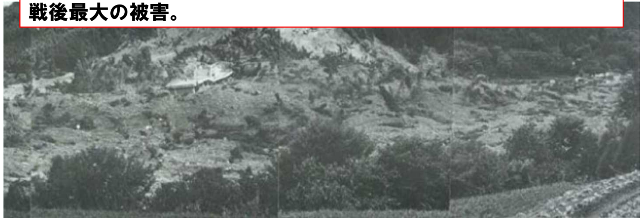
揖保川 宍粟市一宮町福地付近 左岸山崩れにより揖保川を堰き止められた状況
