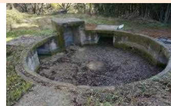
機銃座の状況
