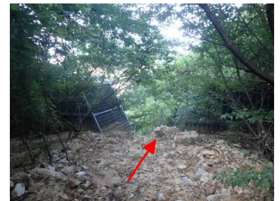
④観音谷川(支溪)堰堤【宝塚市伊子志】
