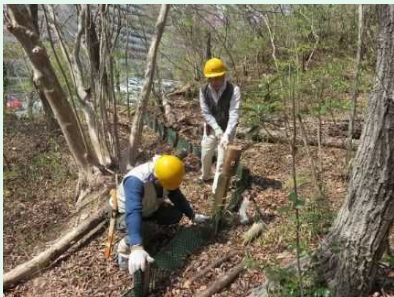
防砂ネットの修復
