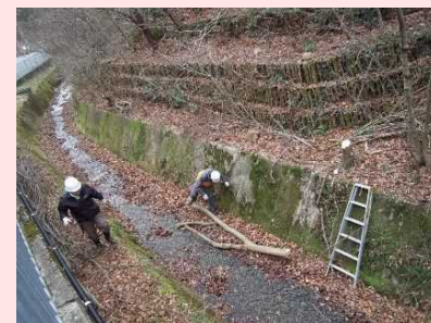
通学路沿いの樹木の伐採
