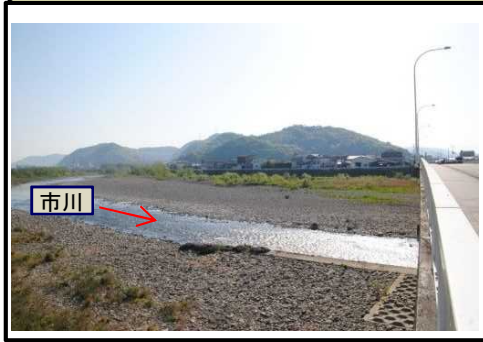
残事業区間(高木橋上流)
