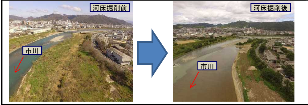
完成区間(高木橋下流)
