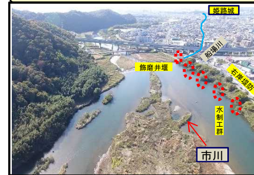
残事業区間(飾磨井堰周辺)
