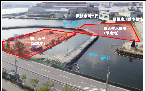
残事業箇所(統合排水機場整備)
