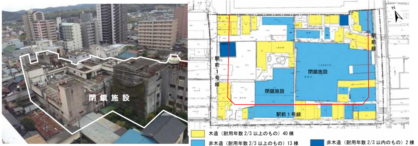
【従前の商業施設の状況（北西より）H26年10月】
