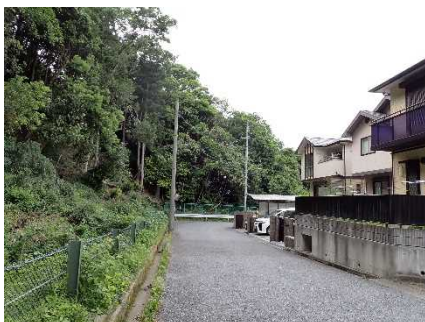
②保全対象とがけの状況
