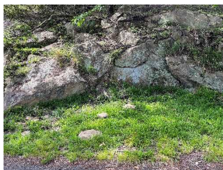
③斜面状況
