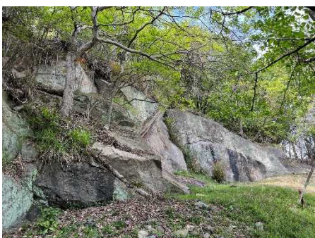
②斜面状況
