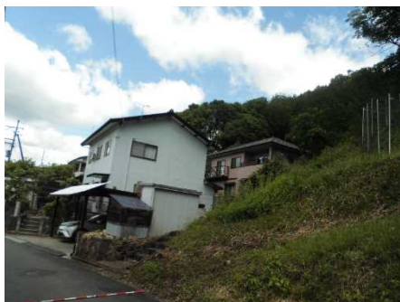
③保全対象とがけの状況
