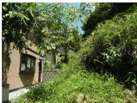
②保全対象とがけの状況
