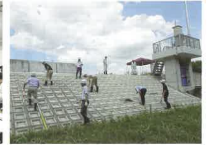
現場実習(河川[維持管理])
