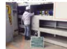
◆防潮ゲートの点検
