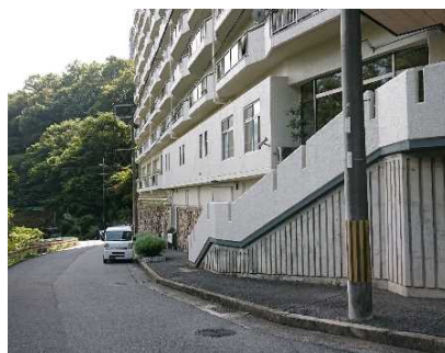
③保全対象(人家)
