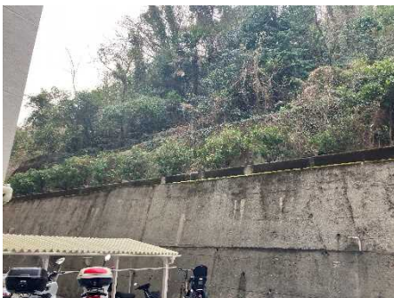
②保全対象とがけの状況
