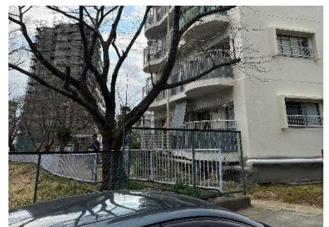
④保全対象(人家)
