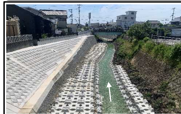
③残事業区間(土山橋上流)
