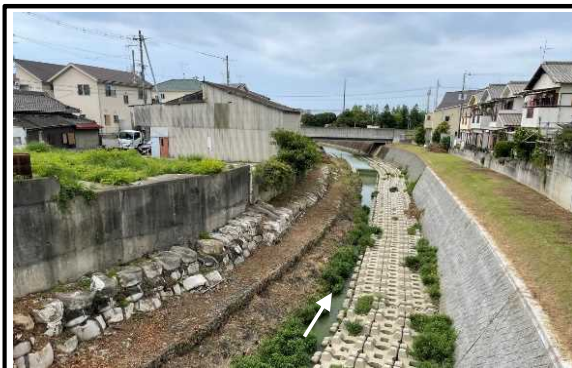
①完成区間(JR山陽本線上流)
