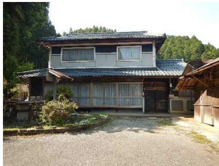
③保全対象(人家)
