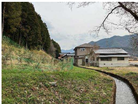
③保全対象とがけの状況
