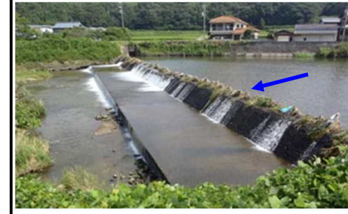
井堰改築(小田井堰)
