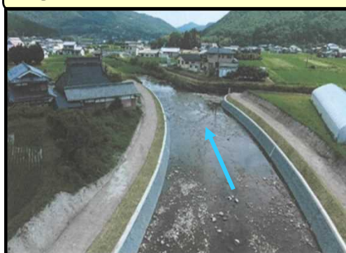
①完成区間 (本荘中橋下流)
