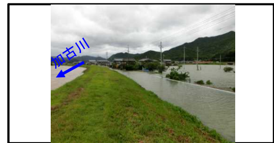
②浸水実績(平成25年台風第18号)
