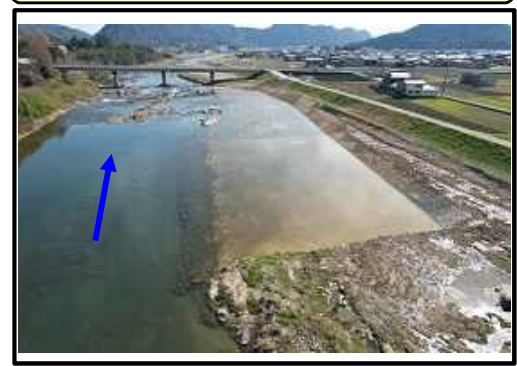
④完成区間(緯度橋上流右岸)
