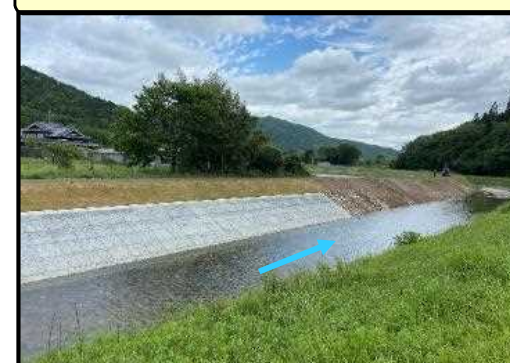
②完成区間 (1号井堰上流左岸)
