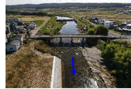
菅田橋(下流から上流を望む)
