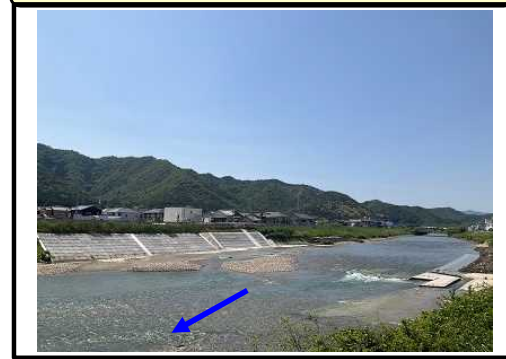
④完成区間(和田井堰)
