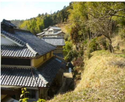
② 保全対象とがけの状況
