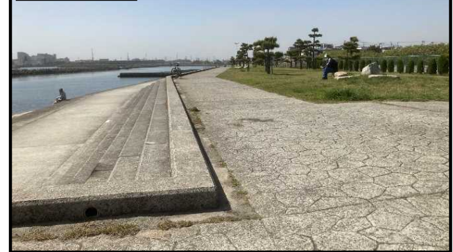
現況階段護岸
