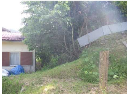
③保全対象とがけの状況
