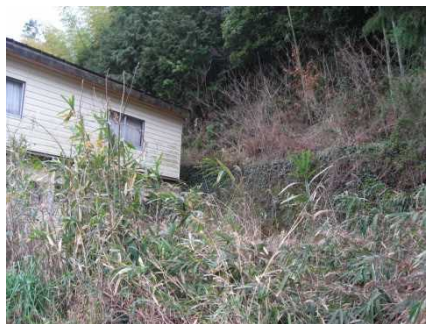
③保全対象とがけの状況
