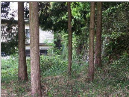
②斜面状況(人家裏)
