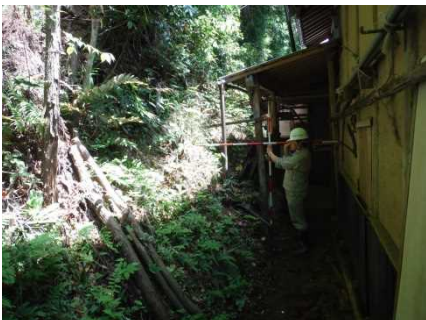
②斜面状況 (人家裏)
