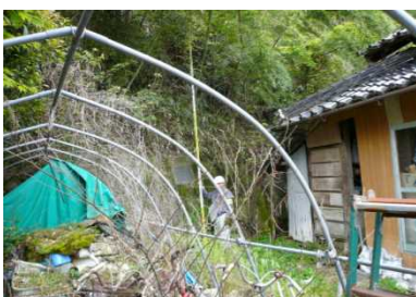
①斜面(人家裏)と保全対象の状況
