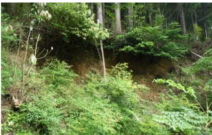
②斜面状況(崩壊跡)
