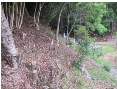
②斜面状況(人家裏)
