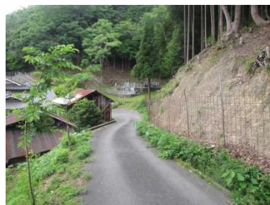
③保全対象とがけの状況
