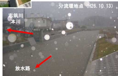
(放水路に分水している状況)
