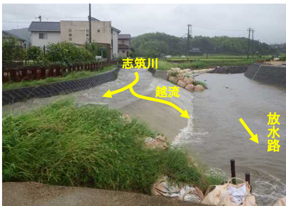
(分流部越流状況)
