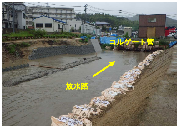
(放水路流下状況)
