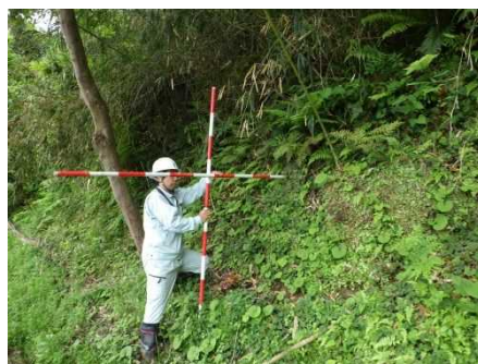
③斜面状況
