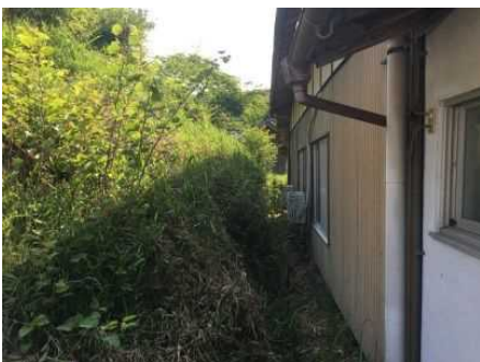
②斜面状況(人家裏)
