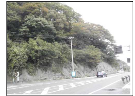
写真2 防災総点検危険箇所
