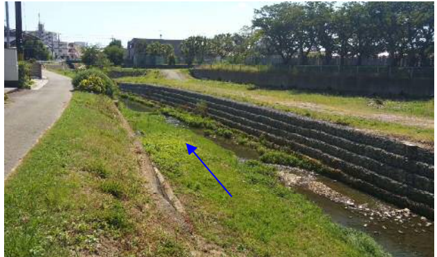
④ 加古川バイパス下流
