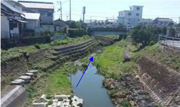
② 国道2号 喜瀬川橋上流
