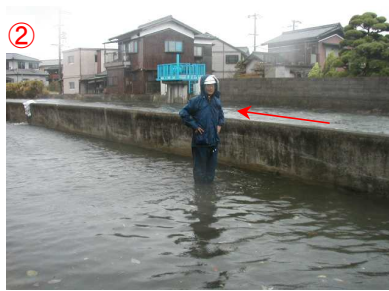
② 浸水状況 (H16.9) [姫路市東山地内]
