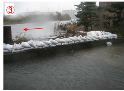
③ 浸水状況 (H16.9) [姫路市東山地内]
