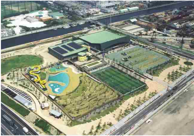
第1工区全景 (H18.4 撮影)
