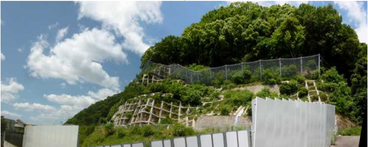
【平成 28 年 6 月時点】 緑の復元途中となる現在の状況
