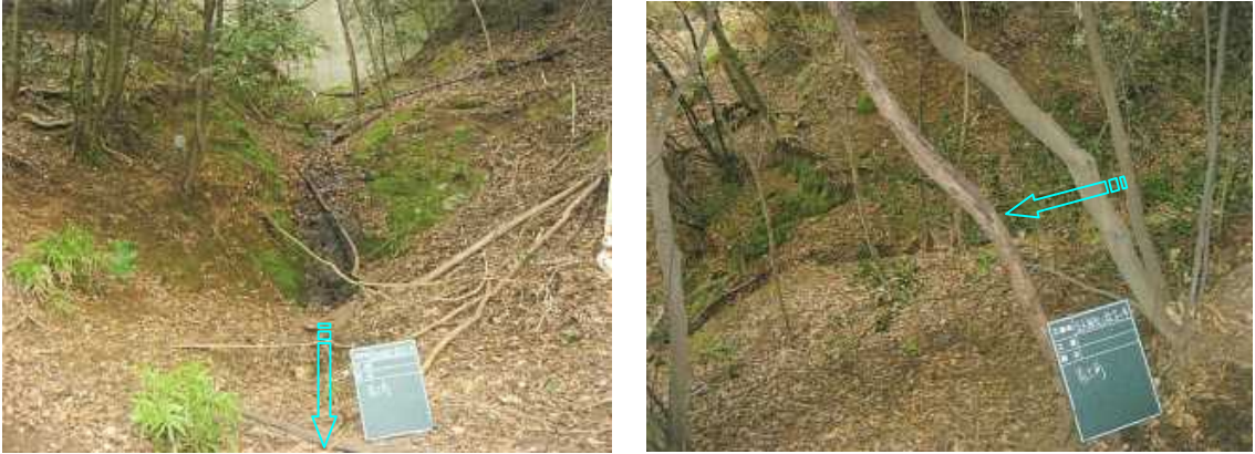
【流木対策工施工前の状況】
