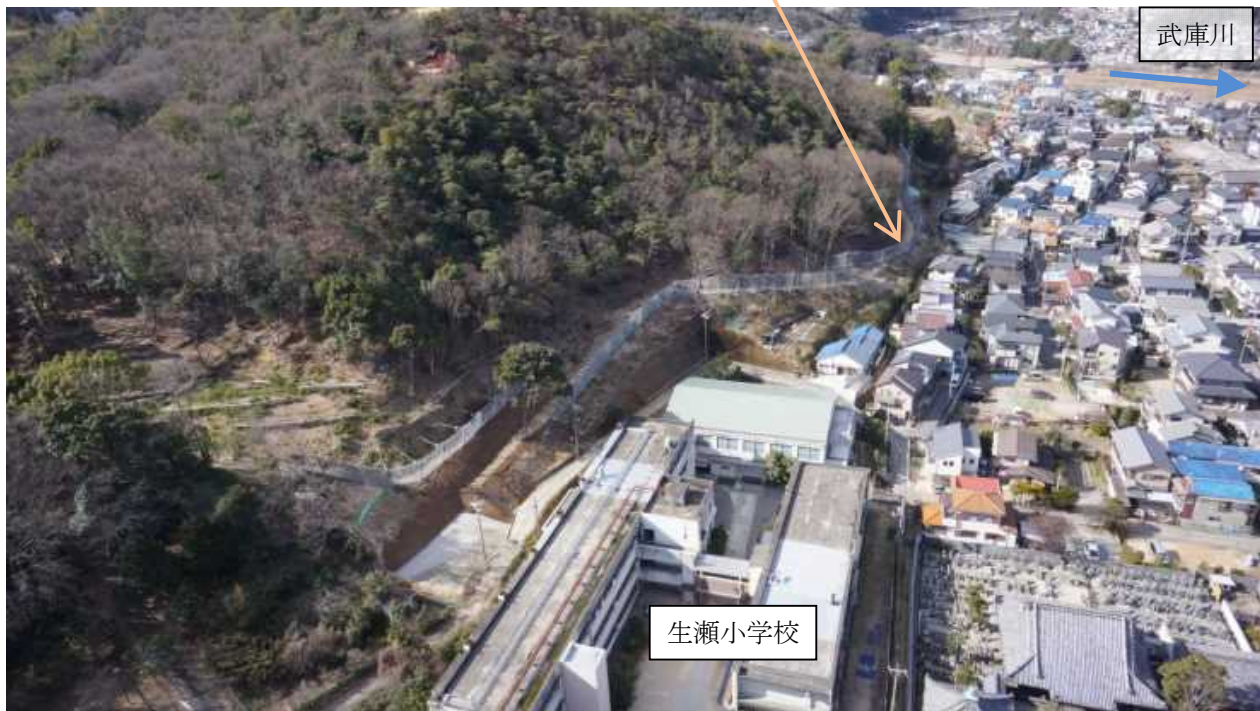
〔平成 24 年度〕山裾部で崩壊土砂を受け止める斜面对策を実施
