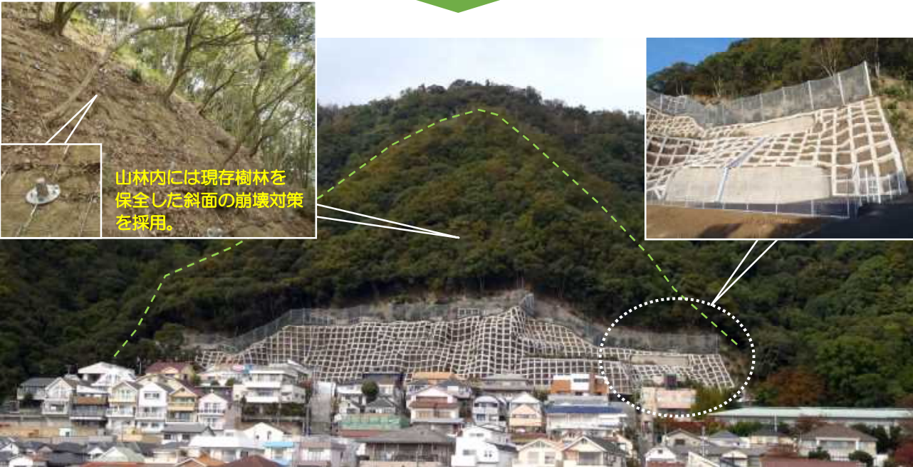
【平成 26 年度完成】 人家裏にある急斜面からの崩壊土砂や落石より人家を守る。
