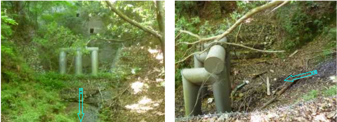
【平成 28 年 現在の状況】
