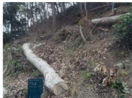
ワイヤーで固定し、簡易な土留柵として、表土の流出等を緩和させる目的で有効活用
