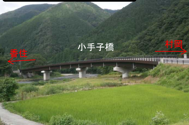
②橋梁部(供用済)の状況
