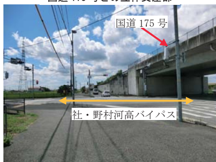
国道175号との立体交差部
