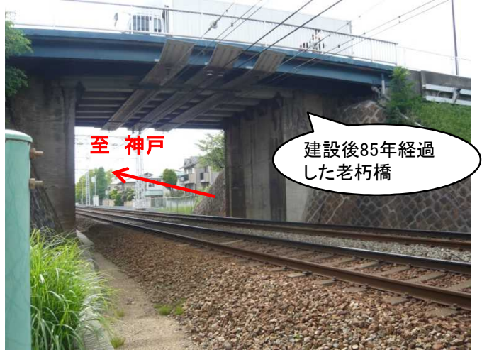
④現況跨線橋
