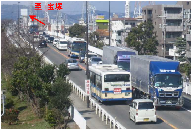
③現況跨線橋盛土部
