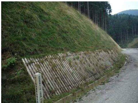
通行車両の視距の確保及び土砂流出防止のための法尻丸太伏工
