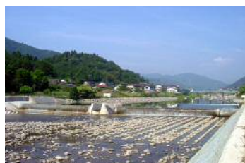
農業用水路 (頭首工)
