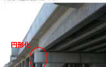
◆環状西線の鉄道交差
