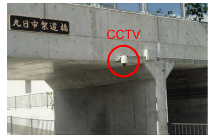
▲CCTVによる道路監視
