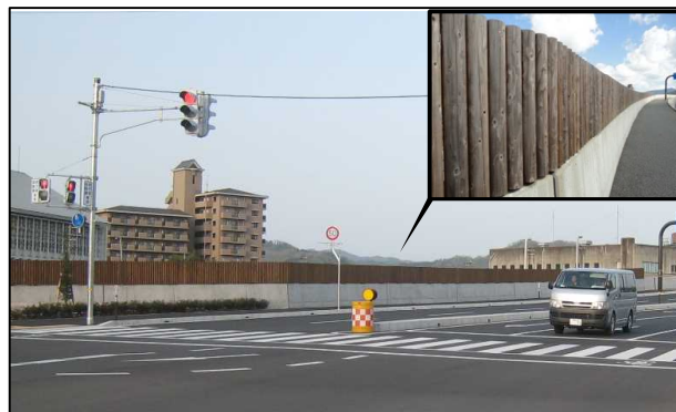
写真① 間伐材を用いた目隠し板（2工区）
