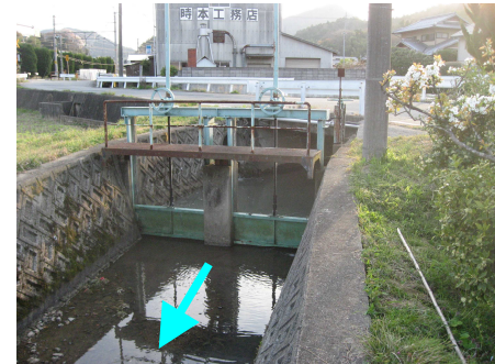
写真④ 既設農業井堰
