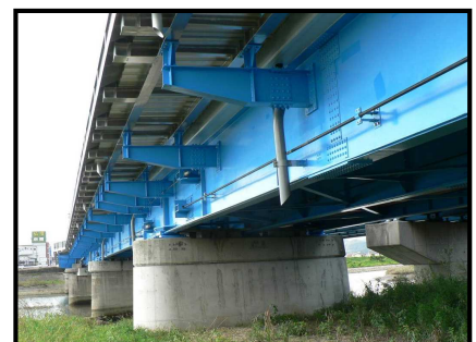
(他橋梁施工事例)
